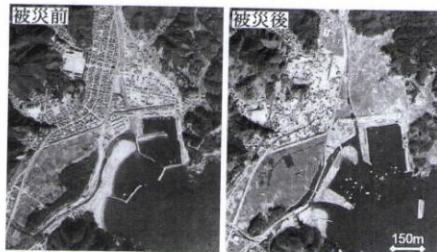
宮古市田老地区の被災前（左、1977年撮影）と震災後（3月13日）の航空写真。湾口の防波堤や、二重の城壁のような防波堤で町を囲み、津波に襲えていたが、高さ10mの防波堤も巨大津波は乗り越えた。防波堤は壊れ、コンクリートの破砕が確認できる（国土建設提供）
